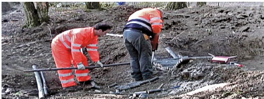
Foto 13 – il piccolo invaso in fase di realizzazione
